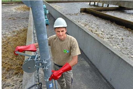
Opérateur usines assainissement en opération de maintenance
