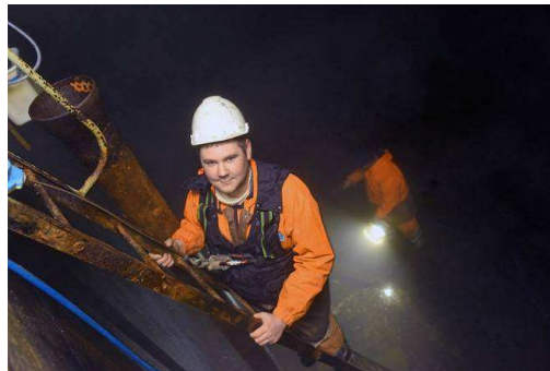
Opérateur usines eau potable en opération de lavage
