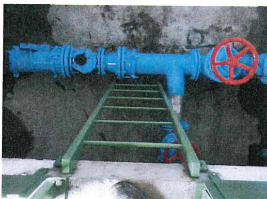
Réfection de la chambre des vannes (peinture conduite, huisserie, Garde-Corps)
