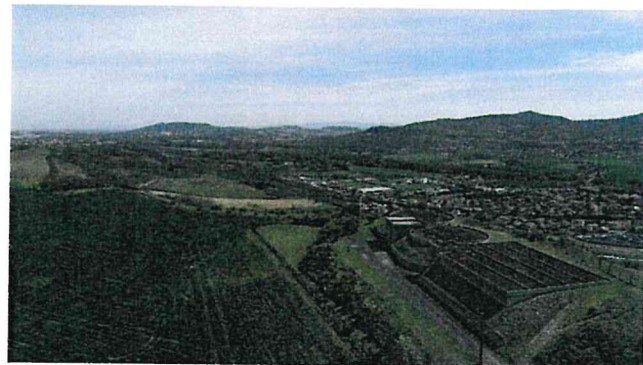
Réservoirs de Tobize – Les Martres de Veyre
