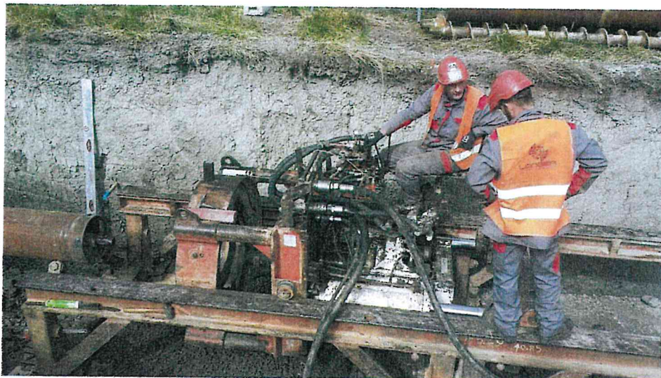
Opération de forage dirigée pour la nouvelle conduite DN 400
