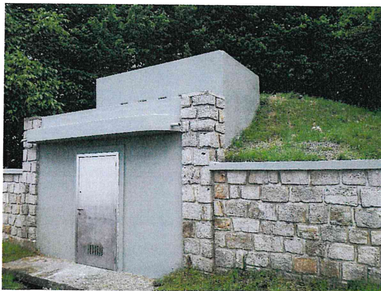
Réservoir de Sauvagnat Sainte Marthe
