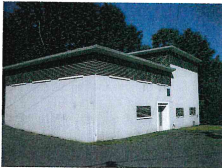
Station de traitement de Rouillas Bas
