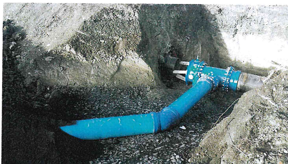
Raccordement du doublement de conduite DN600 / DN 400
